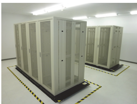
図5. 免震台設置後（ラック搭載後）
