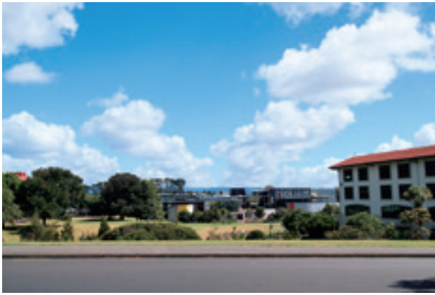
図1 マウント・アルバート・キャンパス外観
