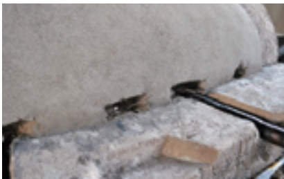
図14 中子修正中の様子。双方の中子の筋金に結わえてある針金同士を縛ることで、中子を強く連結させる。
