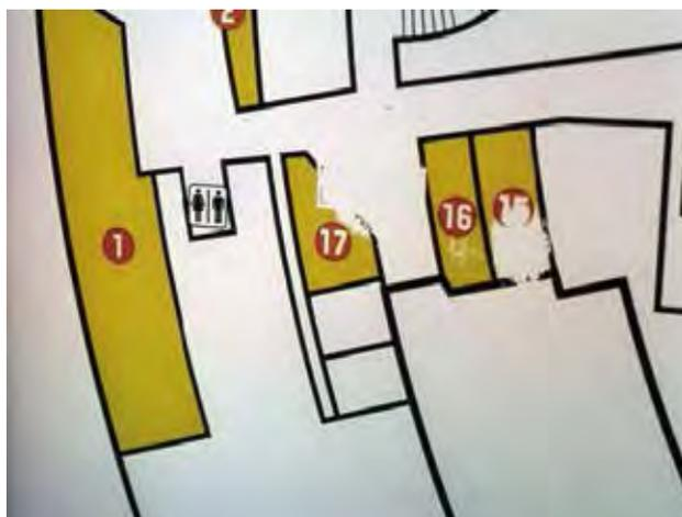
写真7 インフォメーションボードに残された摩耗の痕跡
