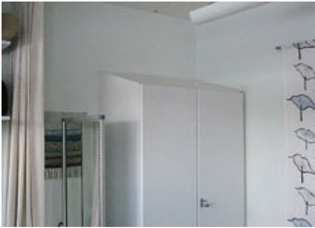
図15 物を置かせないために天板を斜めにデザインした洋服棚
