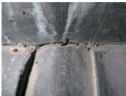
図55 瀧泉寺大日如来坐像上下蓮台 上段蓮台の底部を下段蓮台の膨らみに合わせて研磨している。上下段の隙間から鑄接の湯が漏れ出ている。下段の接ぎ線は直線的で隙間がない。
