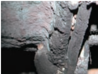
図11 九品寺大仏胎内鑄接痕跡 L字に曲がった先には鑿の痕跡がある。L字は90度よりも小さい角度で、合わせた先に隙間ができる。右側面から胎内を見ている。
