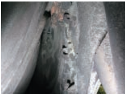
図70 吉祥寺大仏懸裳の裏面 大仏の右から3、4番目の懸裳部品を鑄接するために設けた半環形。鑄接に使用していない。外径3cm、孔径1cmほど。写真左は蓮台上段の表面。
