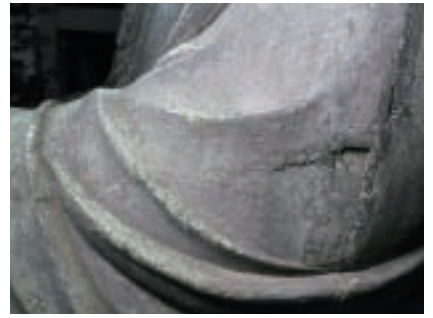
図7 九品寺大仏左体側面 写真右端の縦線が分鑄の接ぎ線で、線の左が「中部」。前に出した左腕の側面に「大寄せ」の分割痕跡があり段差が発生している。
