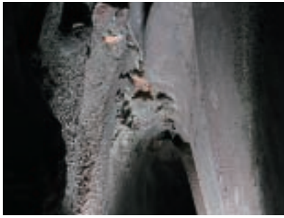
図61 吉祥寺大仏懸裳裏面と蓮台 懸裳と蓮台の隙間。左の粗い鑄肌が懸裳裏面で、右の研磨面が上段の蓮台。懸裳を鑄接した湯が蓮弁上部に張り付いて凝固している。
