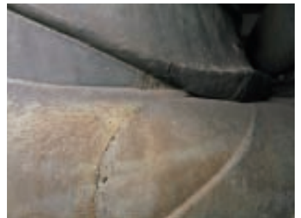
図44 瀧泉寺大日如来坐像腹右側面 図43の鑄接による接合部分の表面の接ぎ線で、直線的で大きな透き間は無い。図40の写真の左寄り（像の後ろ方向）から見ている。
