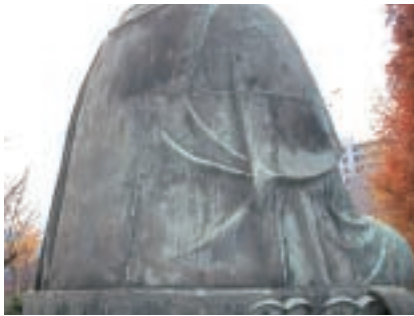
図64 吉祥寺大仏右斜め後方から 接ぎ線の隙間を埋めた金属の色が異なり体部を組み立てた部品が分かる。中ほど横の接ぎ線は強度を高めるため2cmのズレを意図的に作っている。
