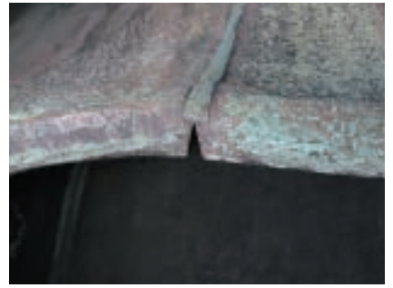
図63 吉祥寺大仏懸裳の小口 懸裳の部品は接ぐ小口を斜めに削って磨り合わせている。その接ぎ線の隙間を塞ぐように軟らかい青銅あるいは銅の帯を象嵌している。
