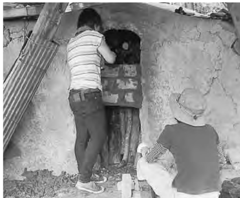
写真 3. 粘土をたたきつけて空気を逃がす
