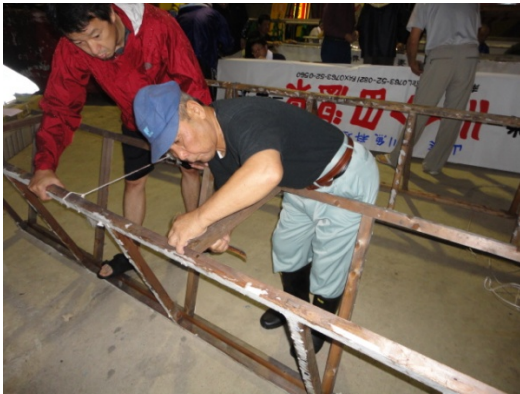
写真 3.添え木の打ち込み作業
