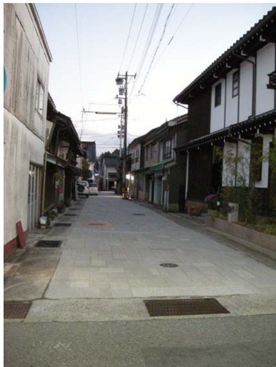
写真 2.石張り舗装が完了して間もない道路
