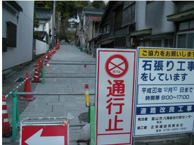
写真 1.石張り舗装の工事中
