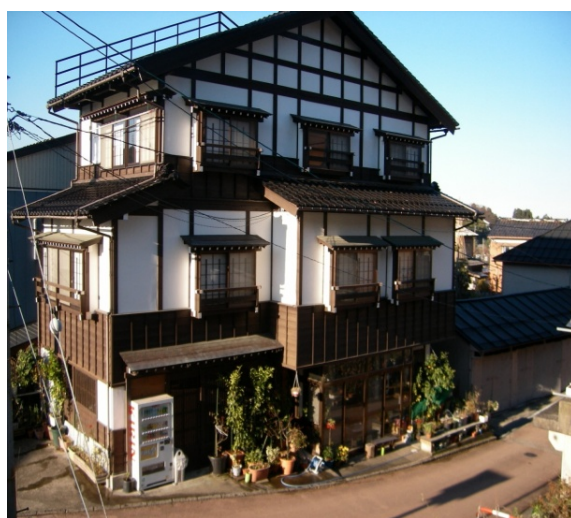
写真9.助成金を利用していない家
