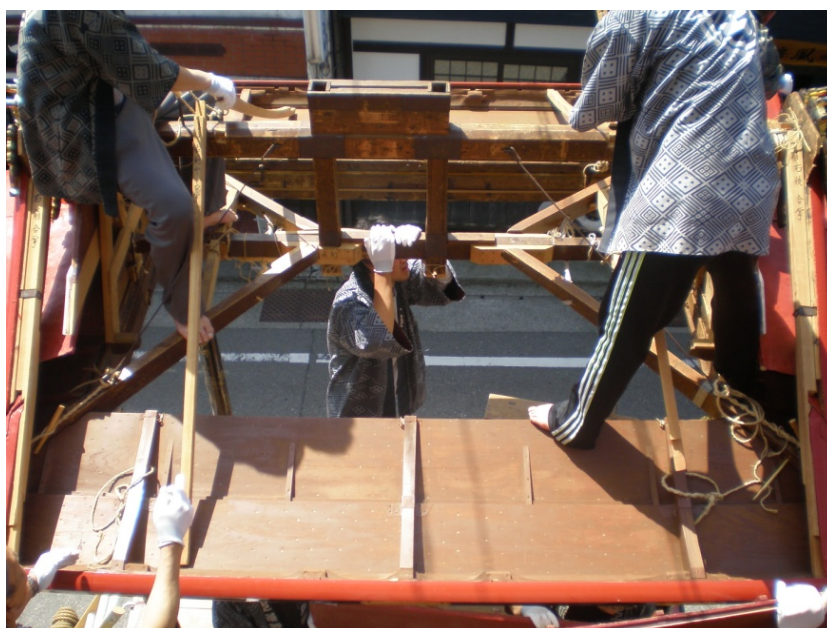
写真.11 曳山解体の様子
