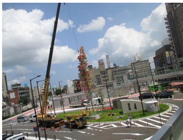
写真 6. ジャンボ七夕の設置作業
