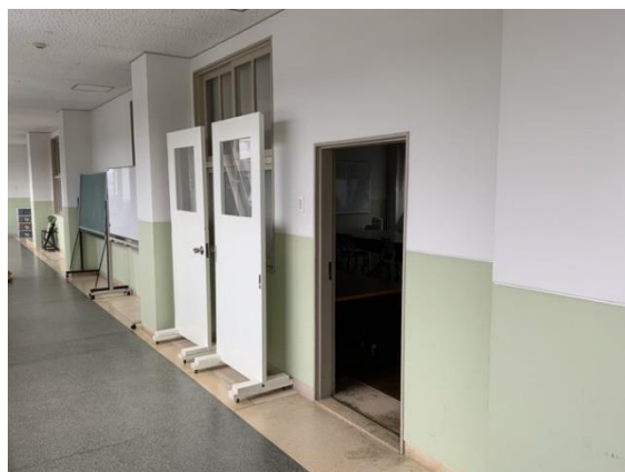
写真 3 C 棟の廊下（筆者撮影）
