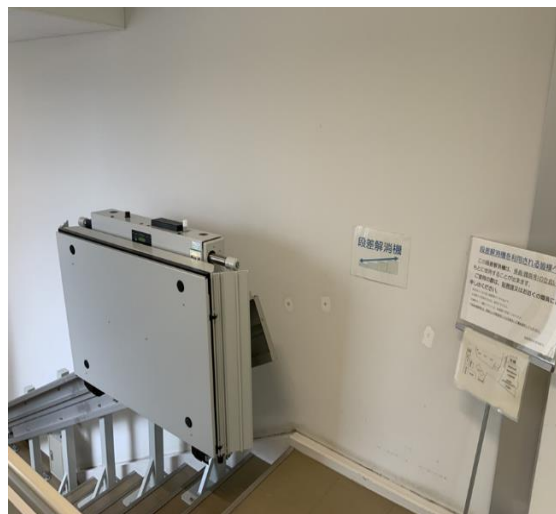
写真 6 B 棟2階と C 棟2階をつなぐ 段差解消機 (筆者撮影)
