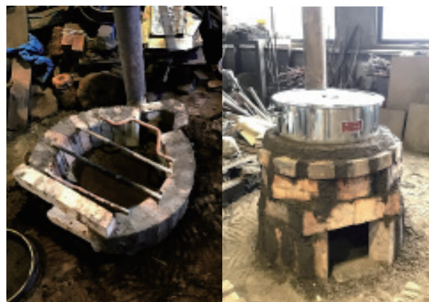
写真1 左：寸胴鍋を乗せる前の状態、鉄の棒の上に鍋を乗せ更に煉瓦を積み上げる。 右：窯の完成した状態。
