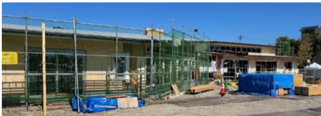
写真2 建設途中の新しいたんぽぽ保育園(筆者撮影)
