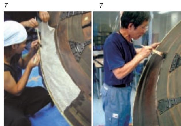
布は、素地の木が動いて亀裂が生じたときに布ごとがはかれて損傷が目立つことを防ぐため、木地の継ぎ目で正確に継ぎ合わせ8分割している。このために作業を二日に分けて4枚を一枚おきに貼る。
