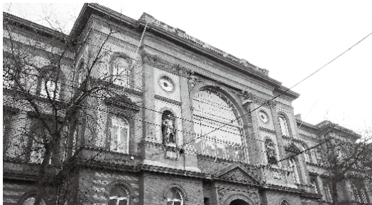
大学病院外観 産婦人科棟
