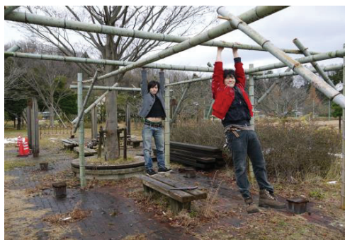
図4 木ダボによる込栓接合で試作されたパーゴラ
