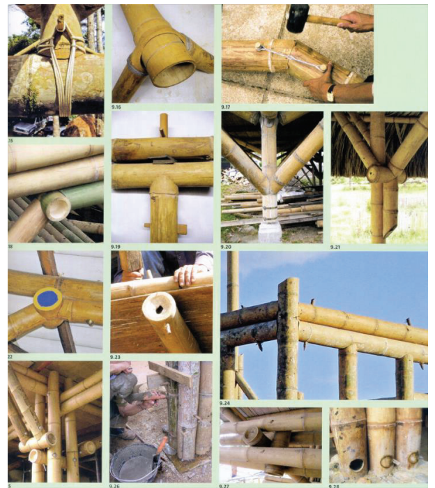
図 1 南米コロンビアで使用されている丸竹材接合法
