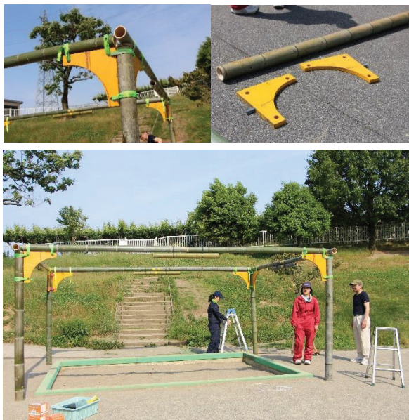
図8 ガセット側面に埋め込んだ込栓（塩ビパイプ）と荷締めベルトによる接合で作られたパーゴラ
