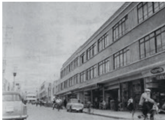
写真5：竣工後の中央通り商店街（1959年頃）（*13）
