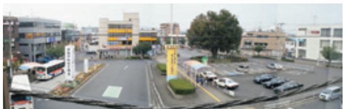
写真1：改修前の北本駅西口駅前広場
