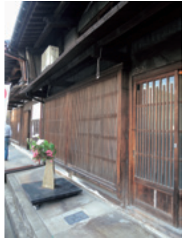
写真2：吉久のさまのこ（千本格子） 他の地域に比べて部材が細く繊細である
