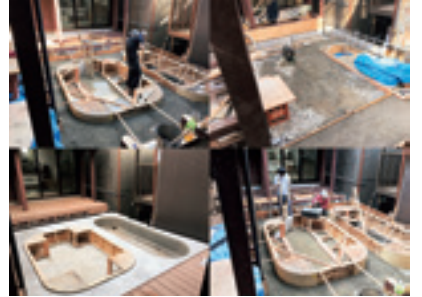
写真5：中庭の版築の制作過程
