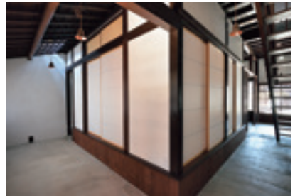
写真6：母屋1階 通り土間
