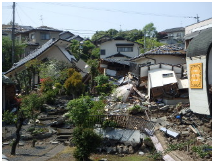
倒壊した家屋。おおむね予測された地震だったが、甚大な被害が出た = 熊本県益城町で4月19日、飯田和樹撮影
