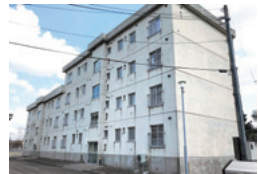
写真1：輪島市移住促進住宅
