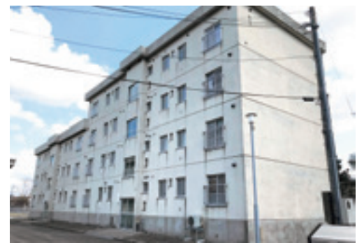
写真1：輪島市移住促進住宅
