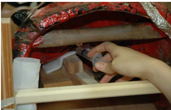
0717-11 内側からもエポキシ樹脂を注射器で注入す る
