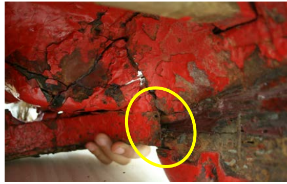
0730-04 接合部の調整（裏側）
