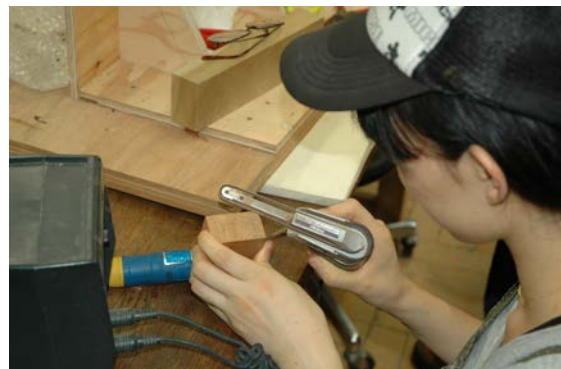
0802-18 充填木材を削る 鉛筆でつけた印のところまでベルトサンダーで充填木材を削る。
