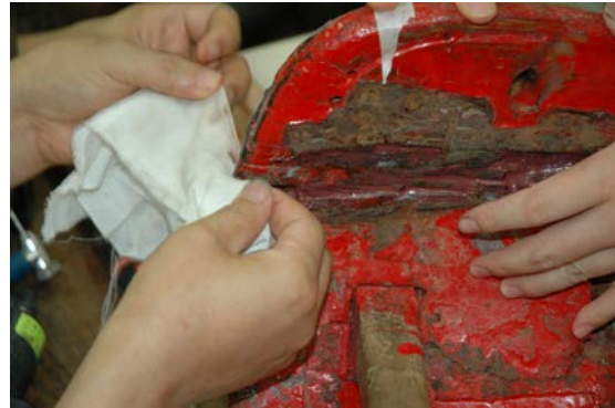
0720-14 接合部端部分の充填剤を布ウエスで落とす。
