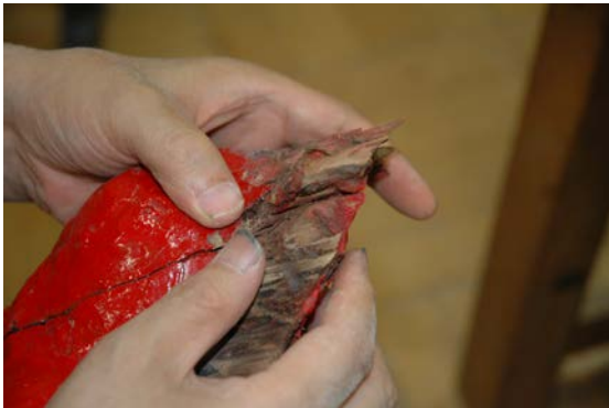
0719-33 右鼻（右側面との接合面）拡大 断面の木材が腐ってふかふかしている。
