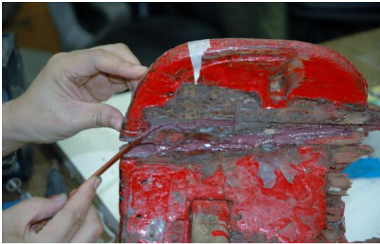
033 接合部の細かな割れ部分も充填していく
