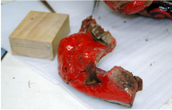
025 取り外された右鼻 断面の木材が腐ってふかふかになっている。
