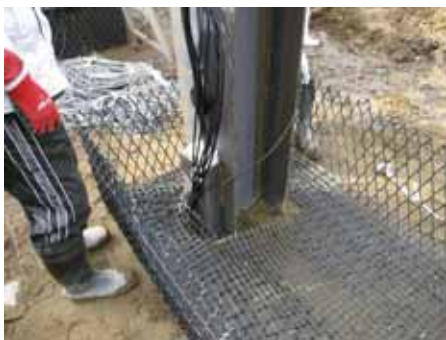
図-4 杭部の補強材の設置
