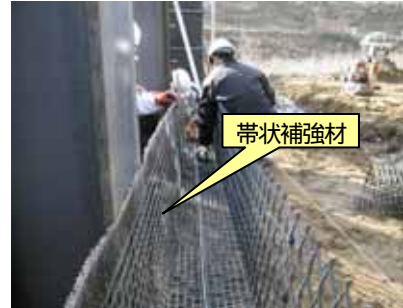
図-5 帯状補強材の設置
