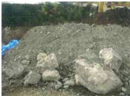
写真-1 施工途中に確認された巨礫
