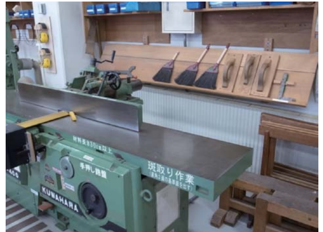
写真24 送材用の補助道具が作業者の方に向けて配置された手押し鉋盤の周辺
