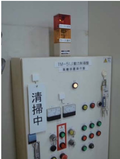
写真16 集塵袋が一杯になったことを知らせる点滅とアラーム装置
