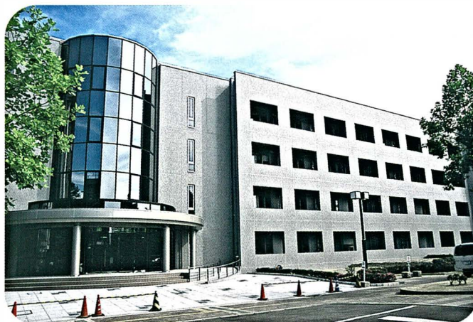
△竣工なった理学部校舎
