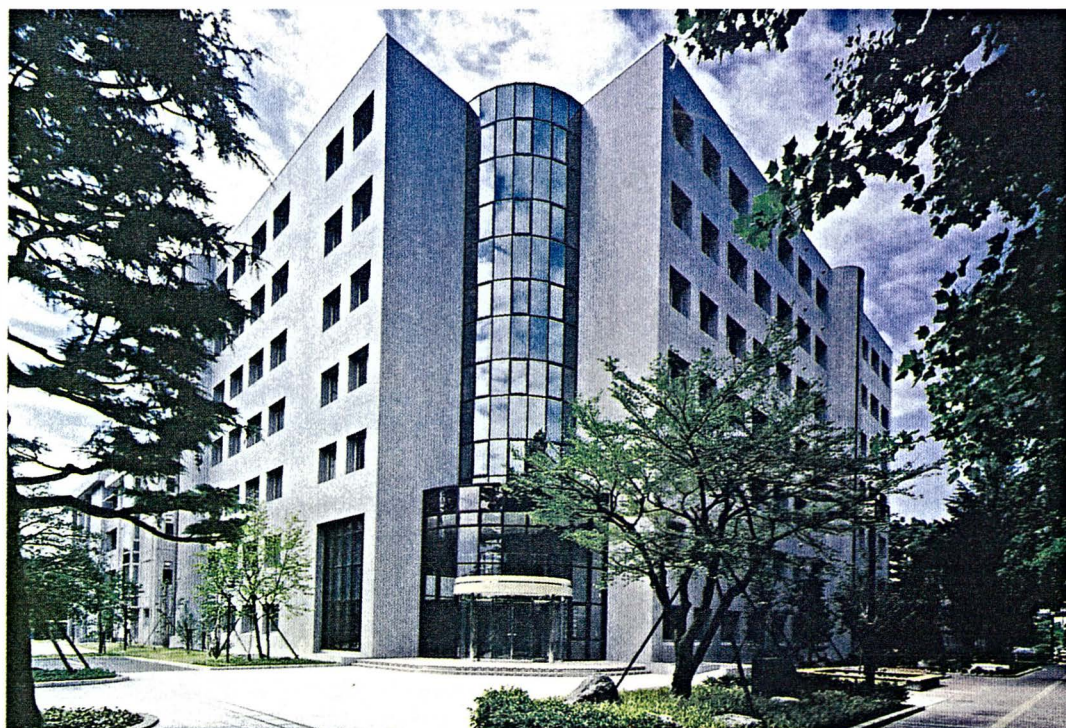
▲ 完成した経済学部校舎
