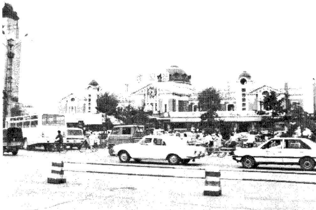
▲ 東京駅を模して建造された赤レンガの瀋陽駅は、旧満洲国を彷彿とさせる
