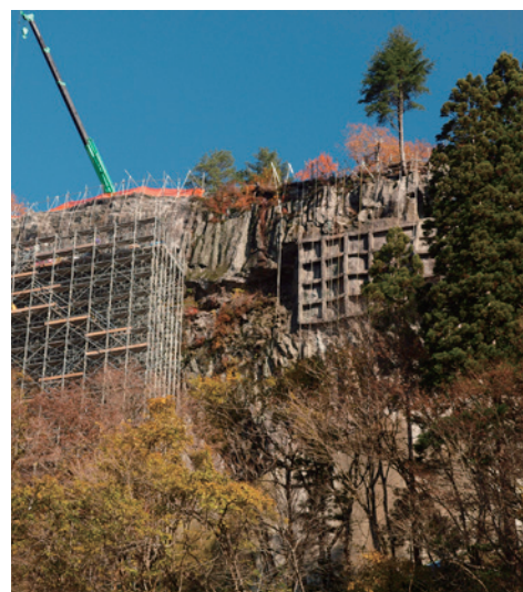
図12 水沼火砕堆積物（ユニットIII）の露頭（三島町早戸）。2012年には工事が進み、露頭の観察はできなくなっていた。
