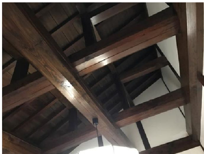
写真5-3 館谷さん宅の2階の天井（加藤撮影）
