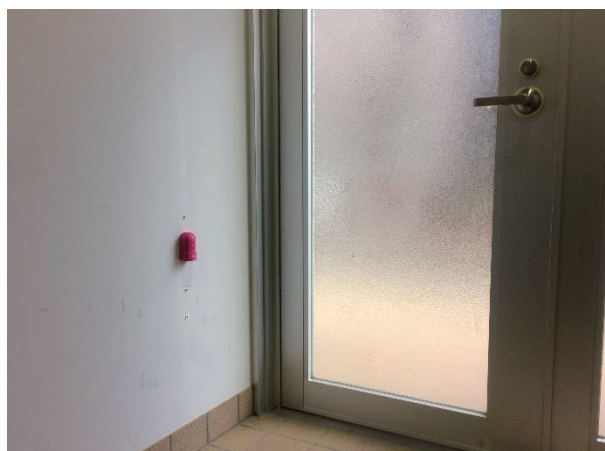
図 8. 職員玄関 (防犯ブザー設置) の様子
