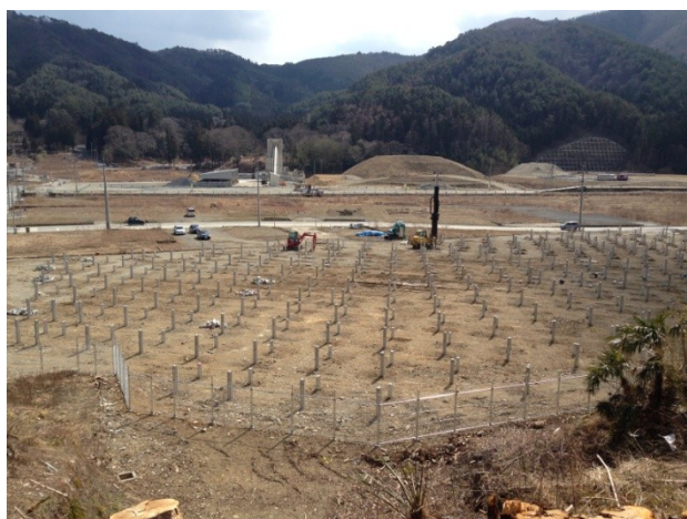
写真 1 太陽光パネルの設置過程
