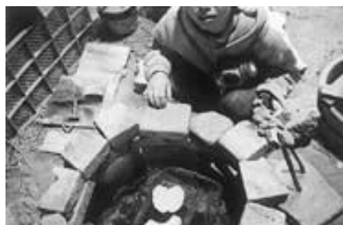
喜多4. 金網に置いて、炭火を下から直接当てて焼く。この方法は、比較的、酸化膜除去が容易である
