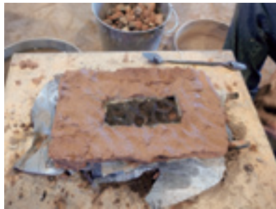
22 乾いたら破片を外して、粘土汁を塗って土 ※2 を置いてゆく。
