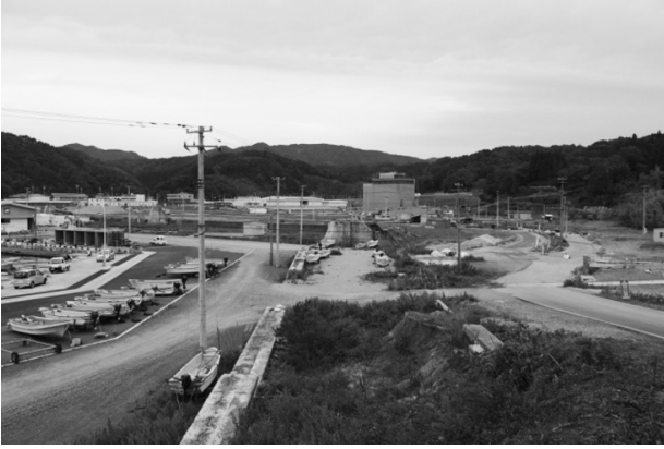
図 2c 新堤防現況 (2015.10) 14.7mのマンモス防潮堤として再建予定
