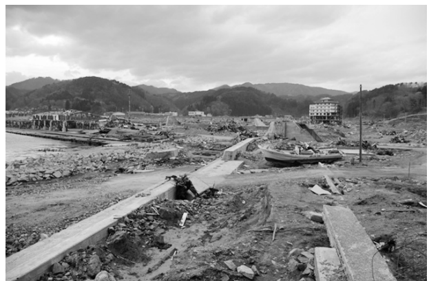
図2b 新堤防（第二堤防）残骸（2011.5）
