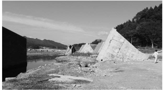
図1 横倒しの堤防（岩手県山田町船越漁港2011.10）
