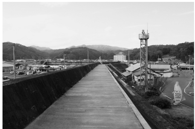
図2a 宮古市田老町の新堤防（第二堤防）（2002.10）
