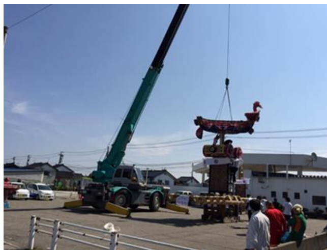
写真 18. 七津屋の組み立ての様子
