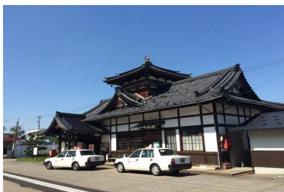
写真 9. 旧井波駅（現井波物産展示館）
