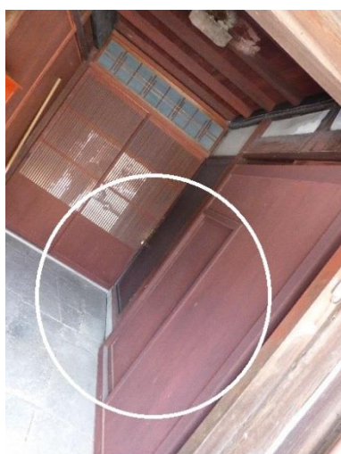
写真3. 右手前の木の戸が大戸、その一部黒丸内がくぐり戸。閉店後の夜間の通用口として使う。強風時には昼間でも大戸を閉め、必要に応じてくぐり戸を使う。
