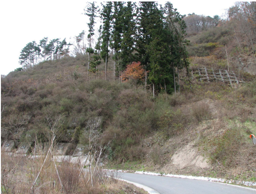
写真4 長野原第一小学校裏手崖の地滑り対策の様子
