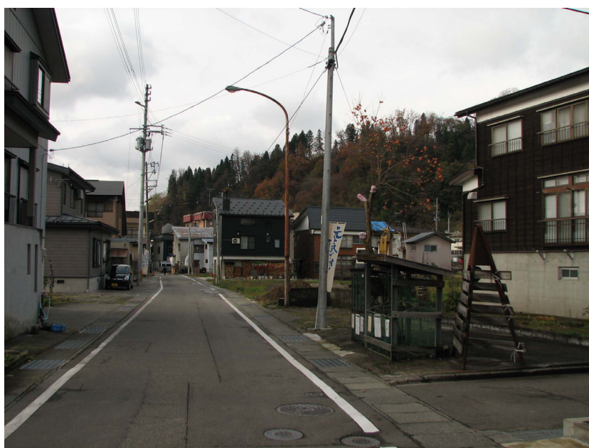
写真2 越後川口町の被災5年後の状況（2009年10月）
