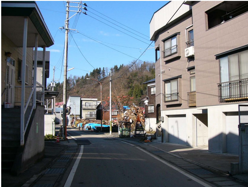
写真 1 越後川口町の被災状況（2004 年 12 月）
