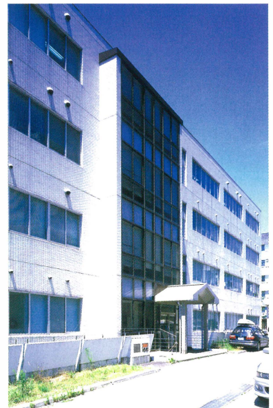
医・薬学部研究棟
