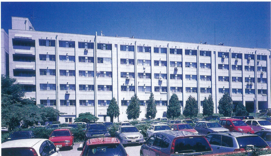
薬学部研究棟
