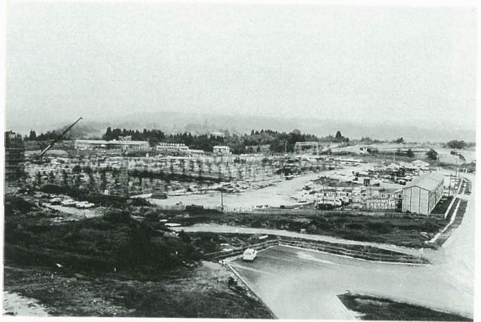
附属病院新営工事①（53年）
