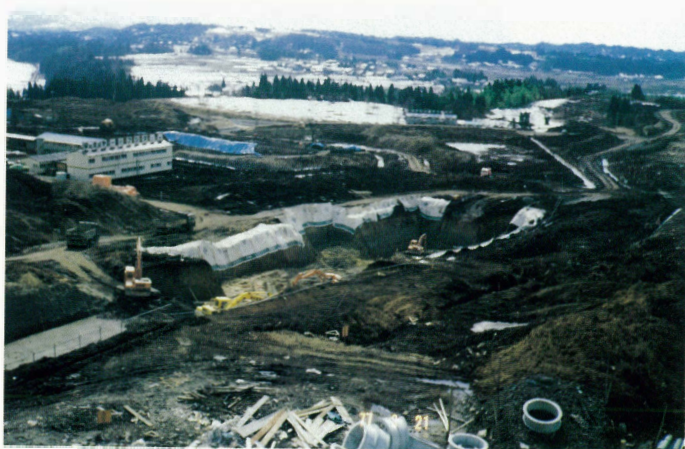
医学部研究棟新営工事（52年3月）
