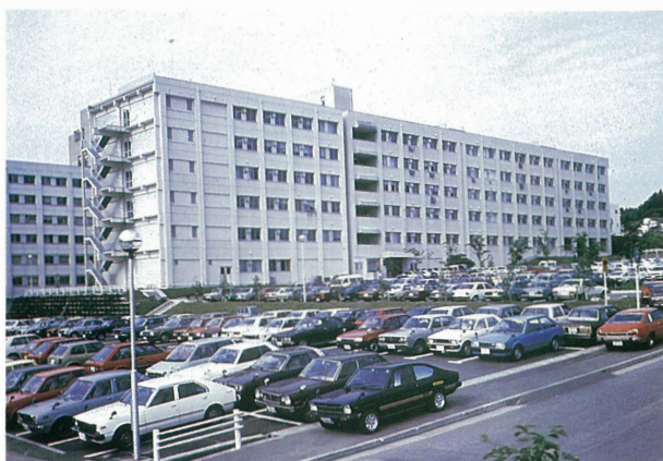
和漢薬研究所・薬学部研究棟
