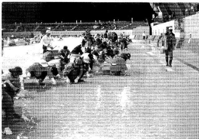
図2 スケートリンクへの巨大単結晶氷の貼付け(エムウェーブ)
