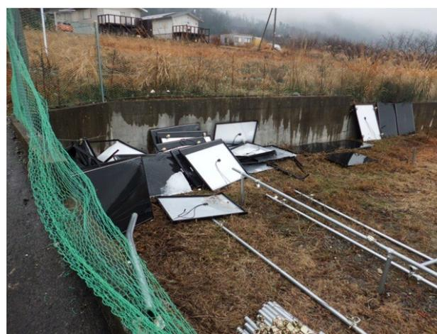
写真6. 強風で施設が倒壊した例
