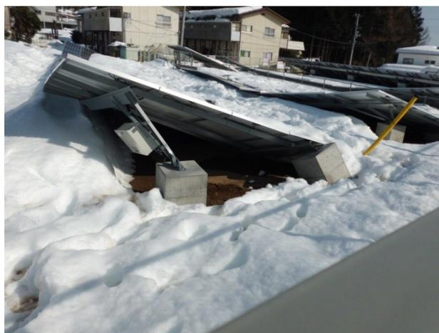
写真5. 積雪で施設が倒壊した例
